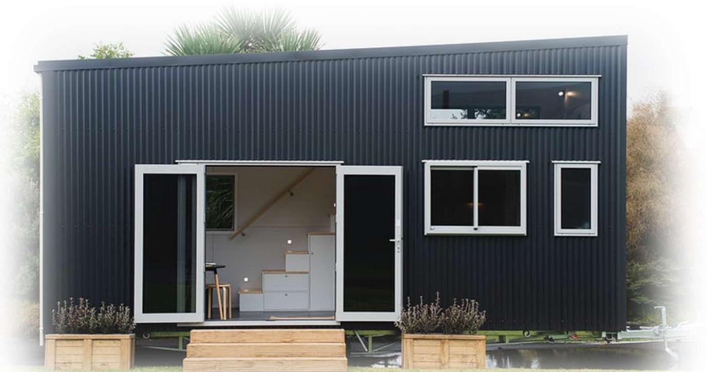
Le système constructif LSF permet aussi de réaliser des petits **logements mobiles** (tiny houses) , lesquels limités à 3,5T ,peuvent être tractés par de simples véhicules pour être installés provisoirement ou plus longuement dans un camping , sur un terrain non constructible, sur un chantier ..autonomes ou raccordés .
